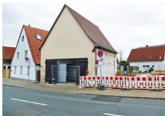
ABRISS FEUERWEHRHAUS IM JAHR 2019
