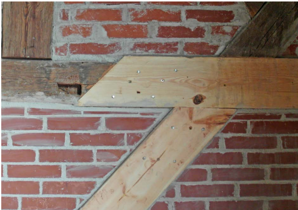
REPARIERTER BALKEN IN DER DORFSCHEUNE
