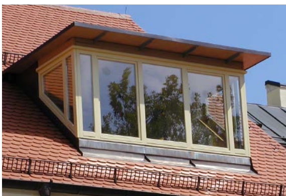
POSITIVBEISPIEL NEUE GAUBE VERGLAST
