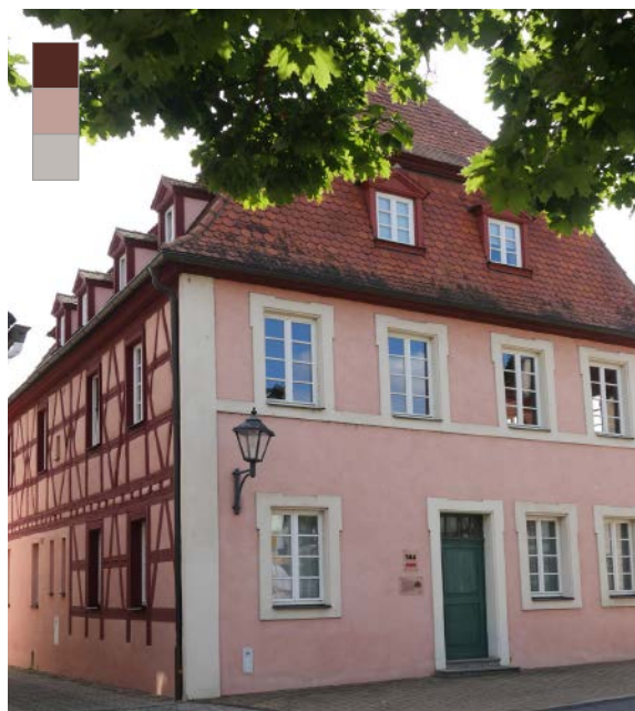
POPPENREUTHER STR. 144 – SCHÖNE FACHWERK- UND PUTZFASSADE MIT EINGANGSTÜR ALS FARBAKZENT
