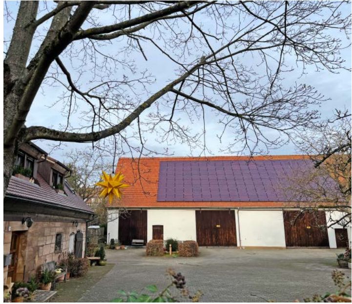
POSITIVBEISPIEL: NATURROTE PHOTOVOLTAIKMODULE - IN EINE RECHTECKIGE FLÄCHE ZUSAMMENGEFASST
