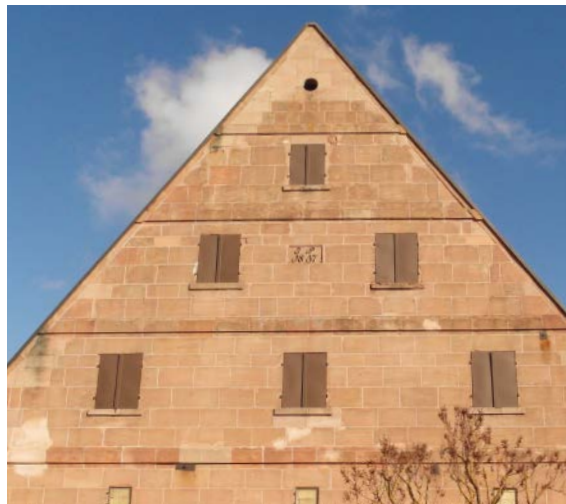
POPPENREUTHER STR. 139 - SCHÖNE SANDSTEINFASSADE
