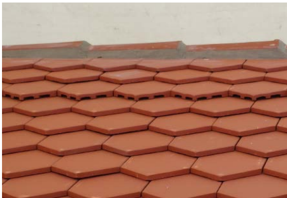
RILLENLÜFTERZIEGEL UNTERHALB EINES VERMÖRTELTEN FIRST
