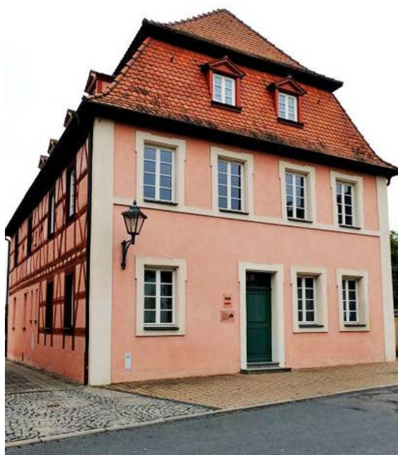
GASTHOF SCHWARZER ADLER 2018 (NACH DER RENOVIERUNG)
