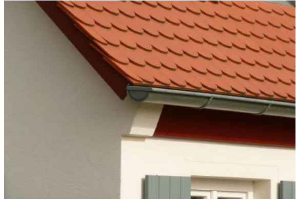
ABSCHLUSS BEI PUTZFASSADEN
