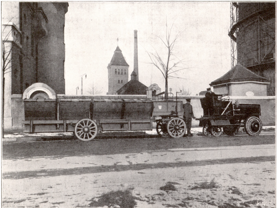
Abb.dO. An kuppeln des Vorspannelektromobils.
