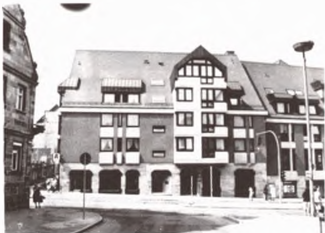
Von einer Super-Spielhalle bedroht: das Gebäude Marktplatz/Ecke Geleitsgasse
