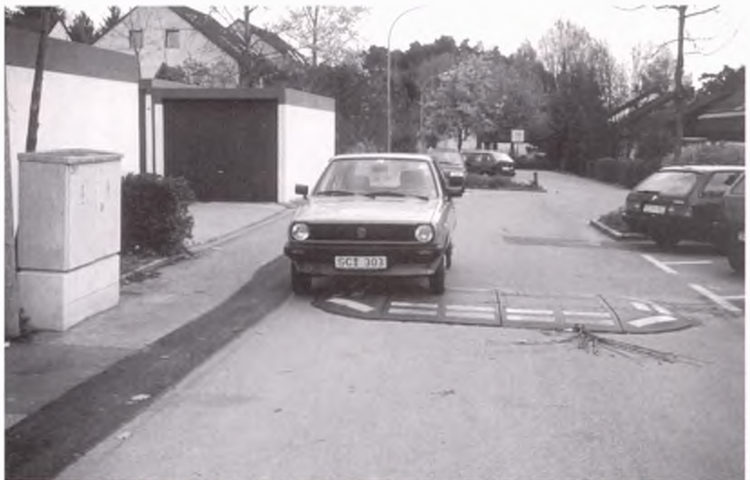
Provisorische Kreissegment-schwelle in der Schwabenstraße in Schwabach. Mit dieser preisgünstigen Lösung konnten Schwellen zur Reduzierung der Geschwindigkeit auch in Fürth ausprobiert werden.
