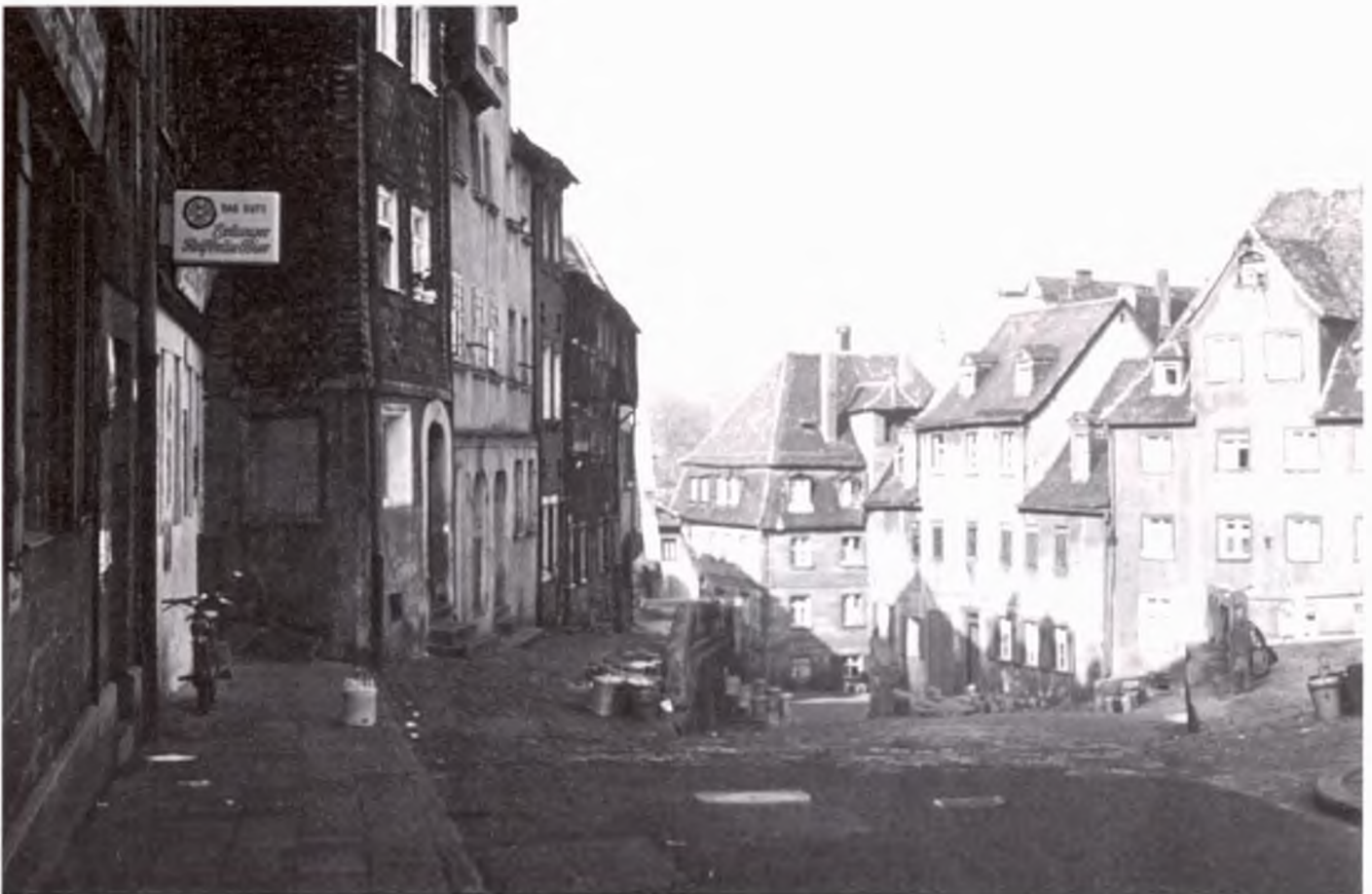
Der Abriß des Gänsberges war die Initialzündung zur Gründung der Bürgervereinigung St. Michael, des Fürther Altstadtvereins. Nirgendwo sonst in Westdeutschland dürfte eine solche Kulturbarbarei (Abriß der halben Altstadt) möglich gewesen sein. Foto von Gerd Hoffmann, Kirchfarnbach.
