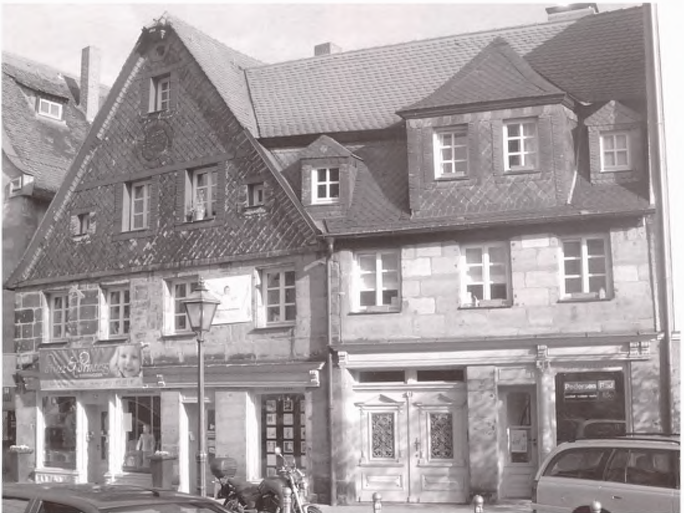
Das Anwesen Gustavstraße 56 heute. Im Vergleich zu 1708 wurden dem Fachwerk Sandstein und Schiefer vorgeblendet, die beiden Gebäude zusammengebaut und die für Fürth charakteristischen gusseisernen Neurenaissance Ladenstöcke eingefügt. Von links nach rechts finden sich heute hier „Prince&Princess“ Kindermoden, Fotodesign Beate Heideck und „Pedersen Rad“.
