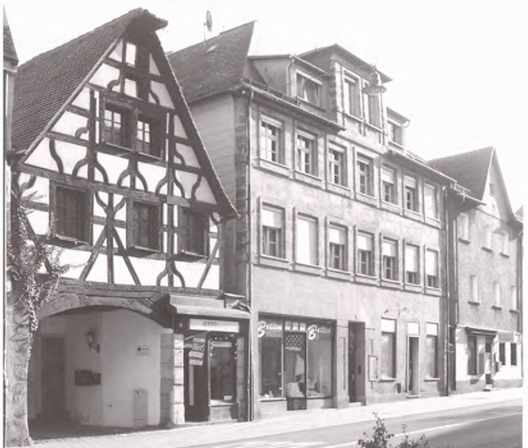
Die Häuser Königstraße 45, 47 und 49. Nr. 45 wurde erstmalig 1753 als Besitz des bambergischen Schutzjuden Wassertrüdingers erwähnt, Nr. 47 ist das einzige Beispiel eines repräsentativen Adelshauses in Fürth, wohl um 1700 von Heinrich Bernhard von Engelschall errichtet. Alle drei abgebildeten Häuser sind schon auf einem Stich von Boener aus dem Jahre 1705 zu sehen, Nr. 49 damals in Fachwerk. Foto: A. Mayer
