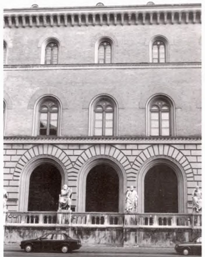
Die Fassade der Staatsbibliothek in München (1834-1839 von Friedrich von Gärtner) ähnelt jener unseres Rathauses. Die Stilformen sind der Palastarchitektur der italienischen Frührenaissance entlehnt.
