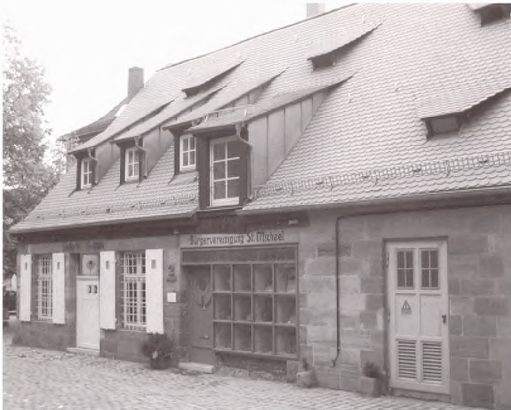
Seit 1989 gehört die ehemalige Freibank dem Altstadtverein, in diesem Jahr wurde Dach und Fassade saniert. Das Gebäude wurde nach dem Brand von 1634 schon 1637 wiederaufgebaut und ist damit eines der ältesten Gebäude in Fürth.
